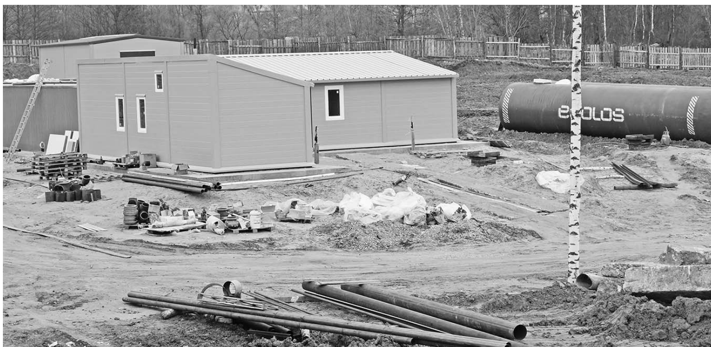
Стройплощадка очистных сооружений в п.Думиничи.
