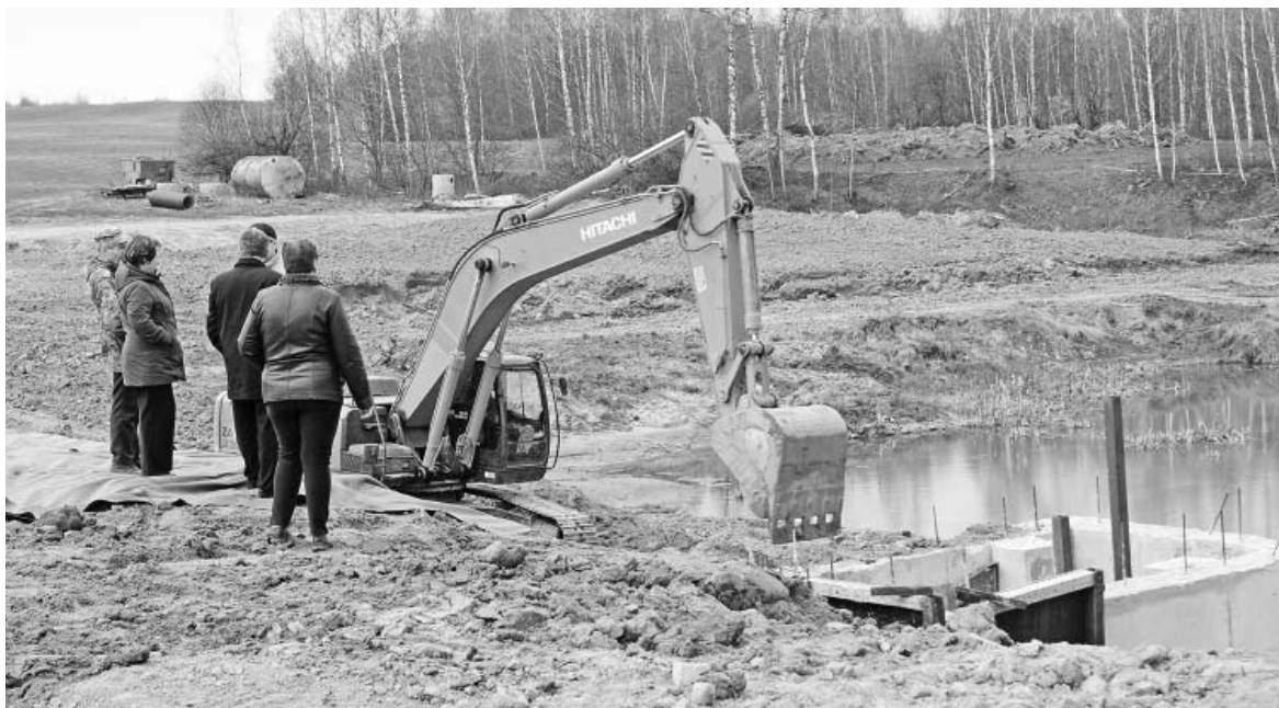
Строительство плотины в д.Гульцово.
